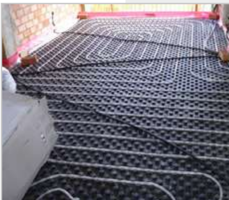
ACS Y CALEFACCIÓN POR SUELO RADIANTE
