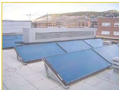
Instalación con paneles planos
