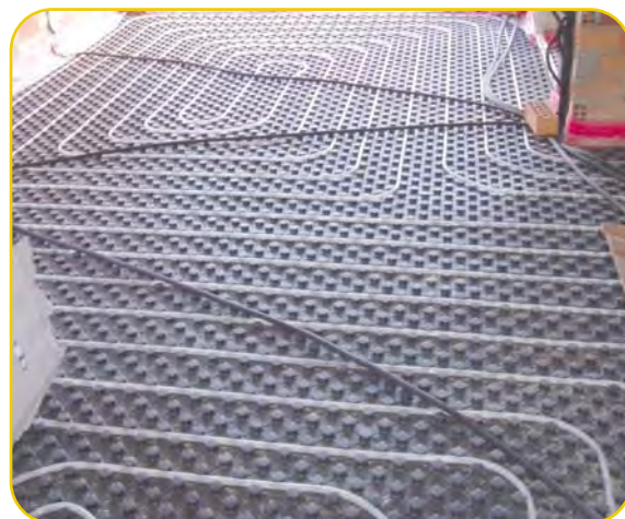
ACS y CALEFACCIÓN POR SUELO RADIANTE
