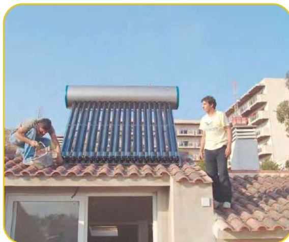
Compacto con tubos de vacío
