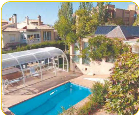
ACS y piscina con tubos de vacío
