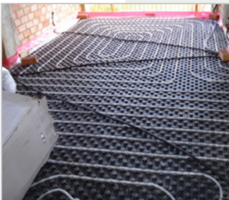
ACS Y CALEFACCIÓN POR SUELO RADIANTE
