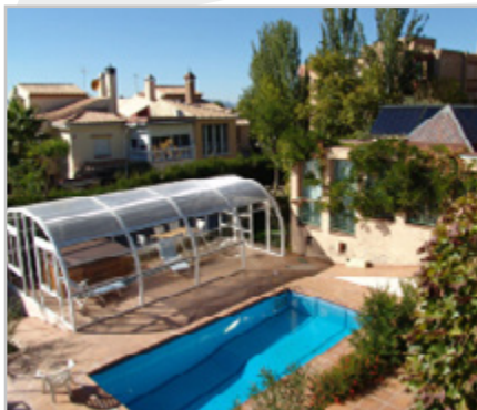
ACS y alberca con tubos de vacío
