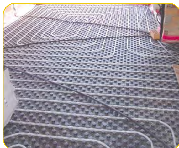
ACS y CALEFACCIÓN POR SUELO RADIANTE
