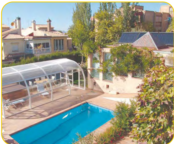
ACS y piscina con tubos de vacío
